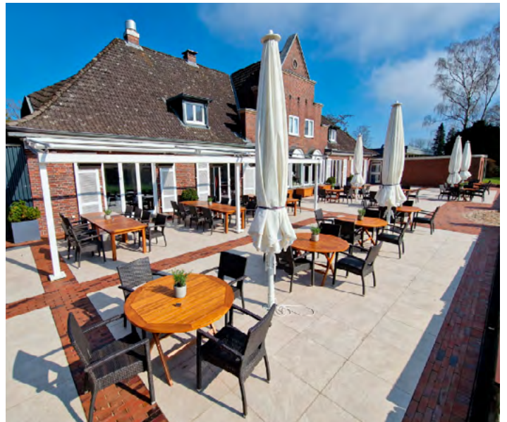
Nach der Umbauphase.
