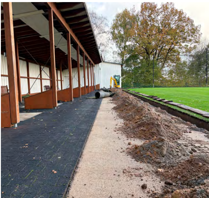
Umbauarbeiten auf der Range ...
