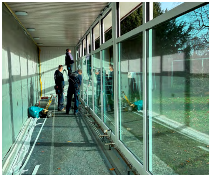
Einbau der Frontscheiben.
