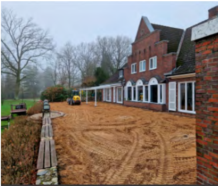
Während der Umbauphase.
