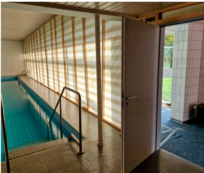
Umbaubeginn mit Staubschutzwand.
